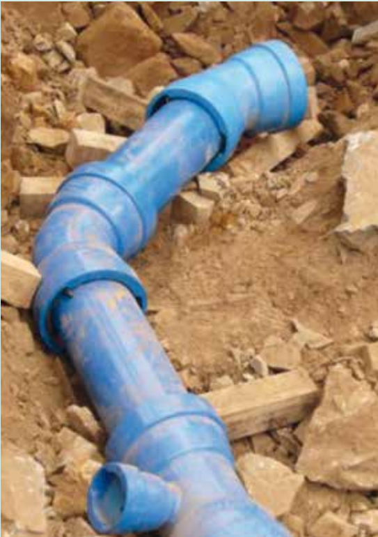
Instalare modernă fără masive de ancoraj din beton
