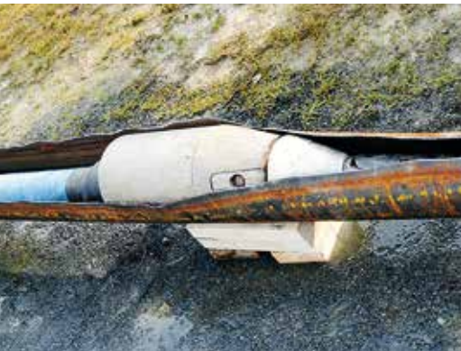
Demonstrație la suprafață a metodei burstlining
