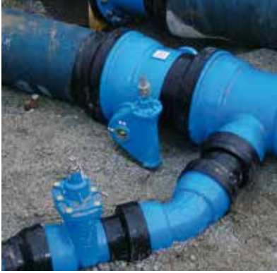
Îmbinare în TVRS®-T/BLS® cu robinet fluture și robinet cu sertar
