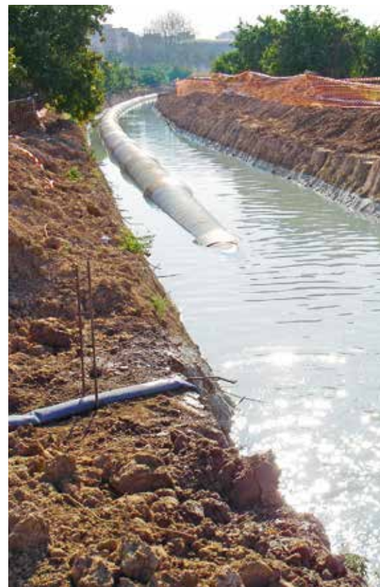
Conducta curbată cu DN 900 instalată prin forare direcțională, Valencia, Spania
